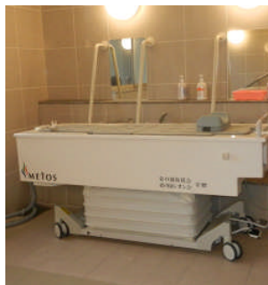
改装された浴室と機械浴槽
