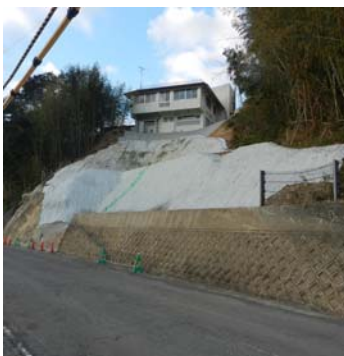
復旧工事を終えた崩落斜面
